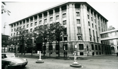
Maison Dorée, avant les travaux, 1975, Archives historiques BNP Paribas, 10FI367.
